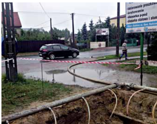
Odwadnianie wykopów podczas prac kanalizacyjnych przy ul. Gen. Kutrzeby
