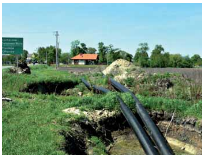
Podwójny przewód tłoczny 2x 315 mm w Borzęcinie Dużym
