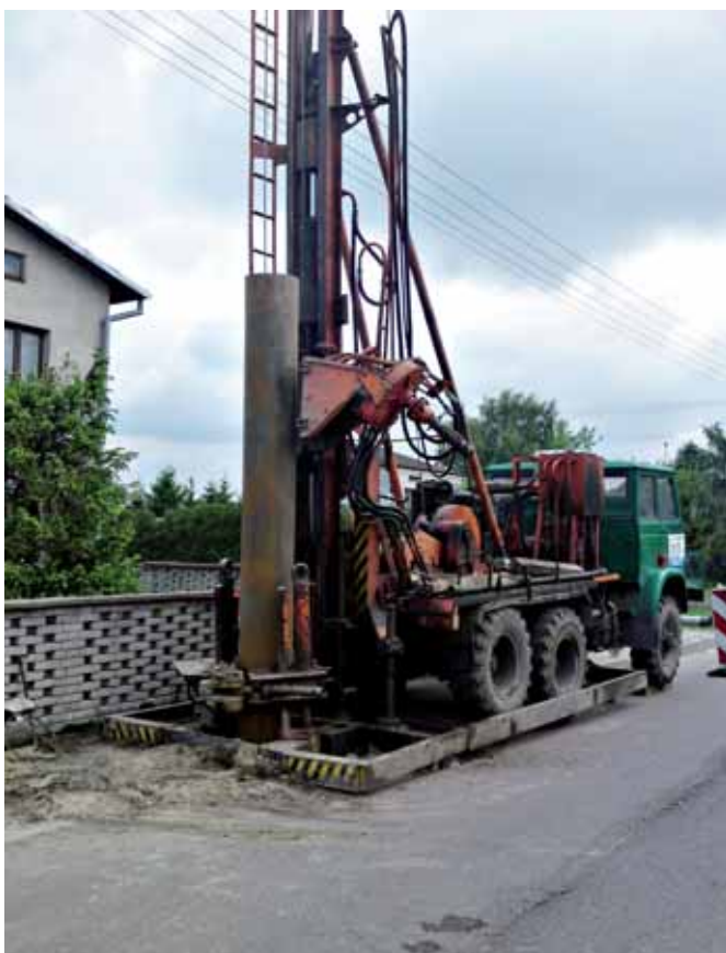
Przy pomocy specjalistycznej wiertnicy wykonywano studnie odwodnieniowe na Trakcie Królewskim w Borzęcinie
