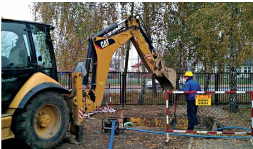
Budowa kanalizacji w Borzęcinie Dużym
