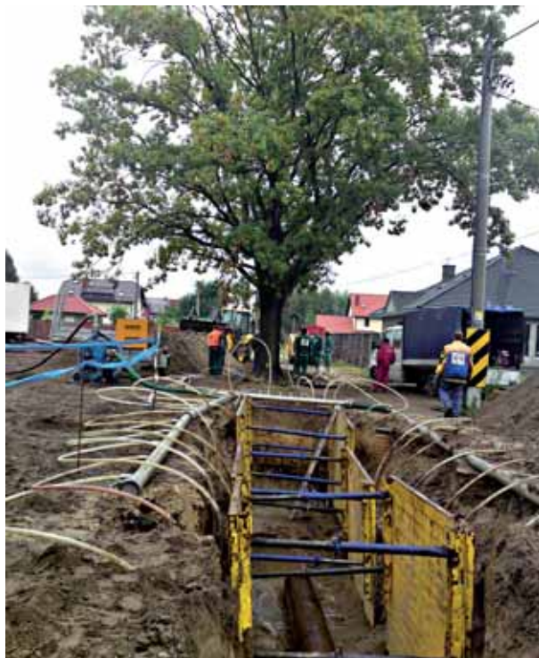
Budowa przewodu tłocznego od pompowni Borzęcin do pompowni Koczargi, w ul. Górki. Pod 70-letnim dębem wykonano przewiert umożliwiający przeprowadzenie instalacji
