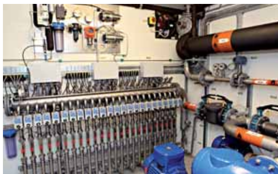
Gaz z 24 odwiertów trafia do stacji indywidualnymi rurociągami
